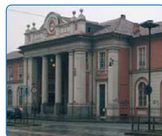
Stazione ferroviaria Torino-Ceres Corso Giulio Cesare, 13 - Torino
